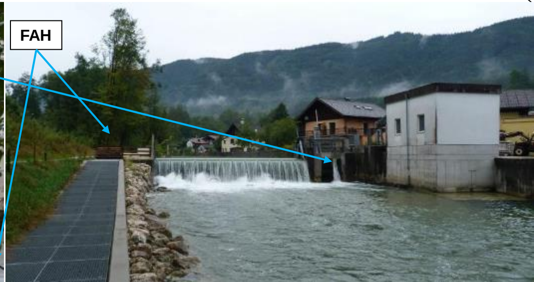
Abstiegsöffnung Davor: Leitrechen
