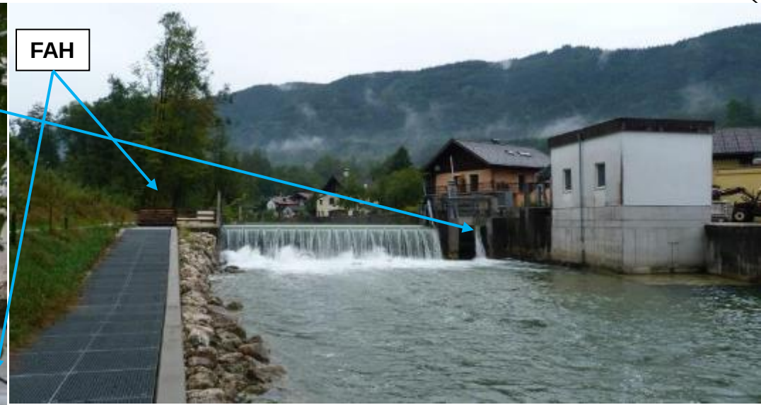
Abstiegsöffnung Davor: Leitrechen
