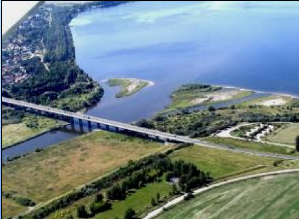
Einlaufbauwerk – fester Wehrkörper aus Stahlbeton
