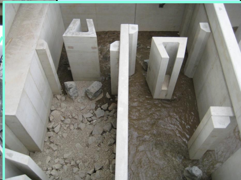
Baugrube: Stauhöhenvariables Einlaufbauwerk
